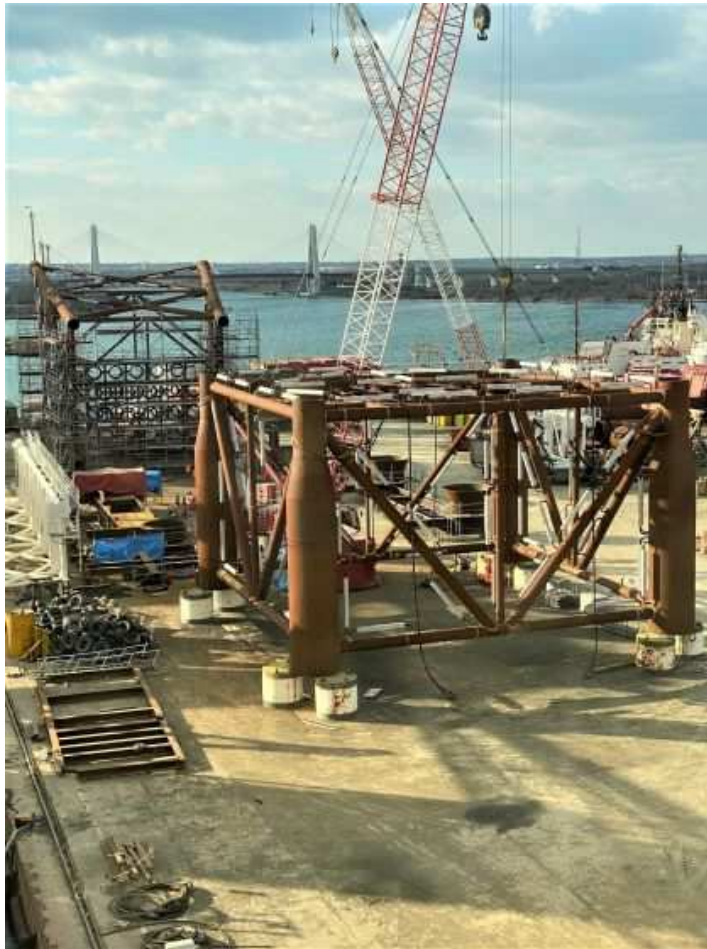
Η υπό κατασκευή εξέδρα Lamda που προορίζεται για την ανάπτυξη του κοιτάσματος Έψιλον
